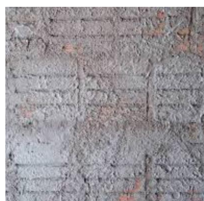
Figura 2. Chapisco Fonte: Autor
