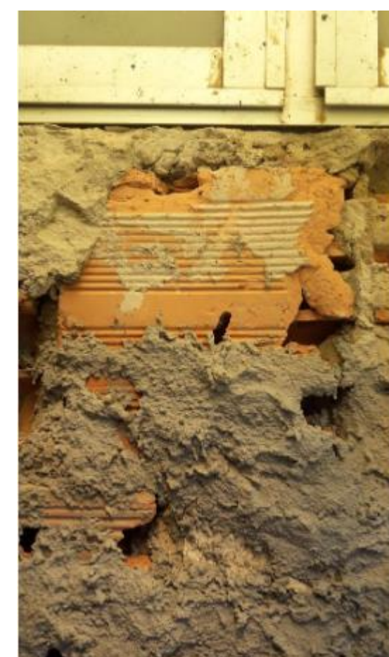
Figura 1. Estrutura em vias de tijolos Fonte: Autor
