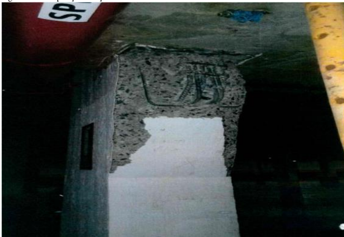
Figura 1. Má disposição do aço nos consolos
